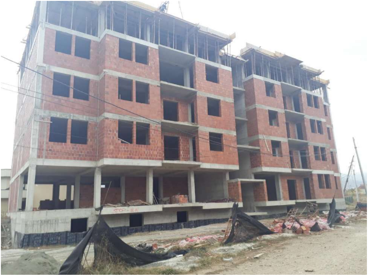
“Petrovë” Mahallesi, toplu yaşam konutu! Bina inşaât sürecindedi 30 daire kapasitesindedir.
